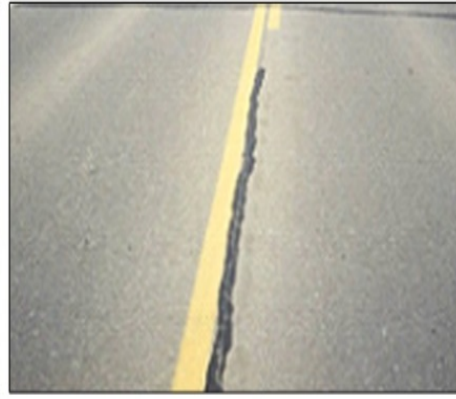
Longitudinal Cracking
