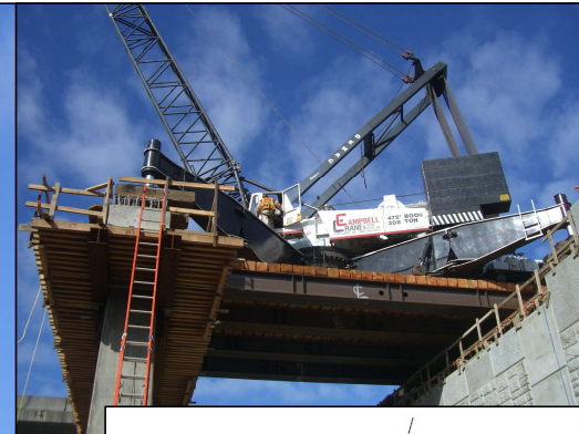
80 Ton Precast Arch Rib Segments
